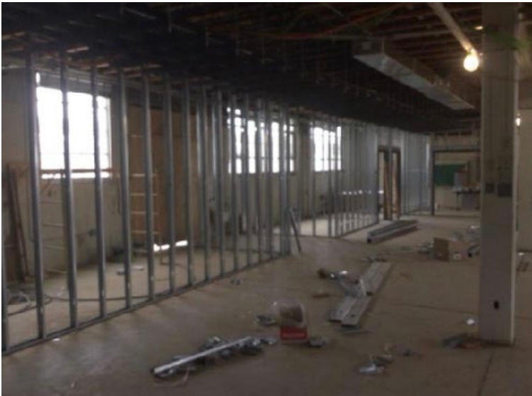
Metal Stud Framing Ongoing
